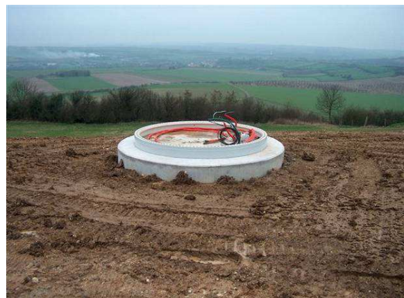
Figure 17 : Réalisation de fondation à la centrale éolienne de la Haute-Lys (Pas de Calais) – source : POWEO ENR
