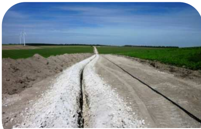
Réalisation des pistes et du câblage
