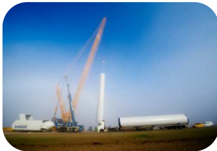
Montage des tronçons de mâts
