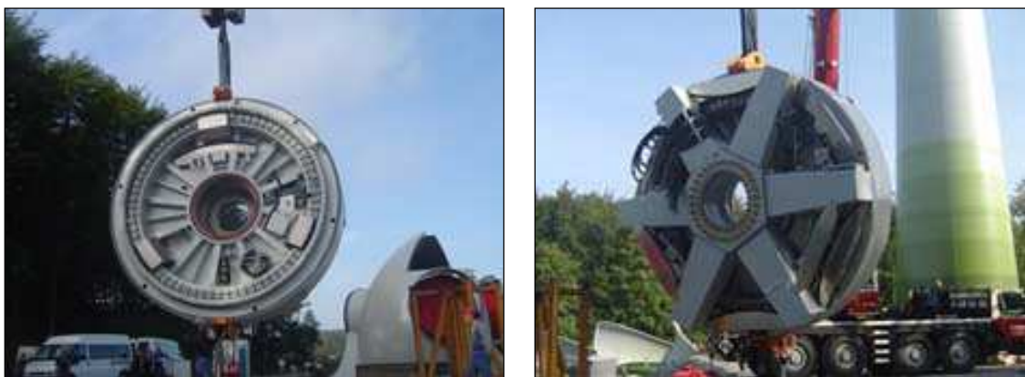
Figure 21 : Générateur annulaire – Source : Enercon/Grennelec
