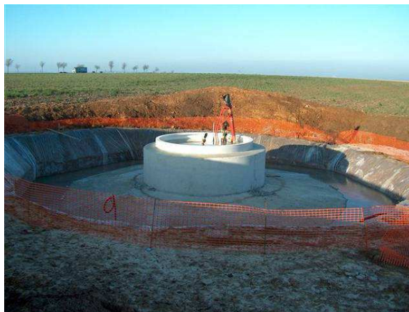
Figure 16 Visualisation du décaissement et du ferrailage réalisés pour les fondations – Source : NEOEN
